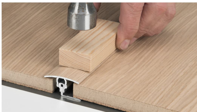
Instalace přechodového profilu hliníkového
