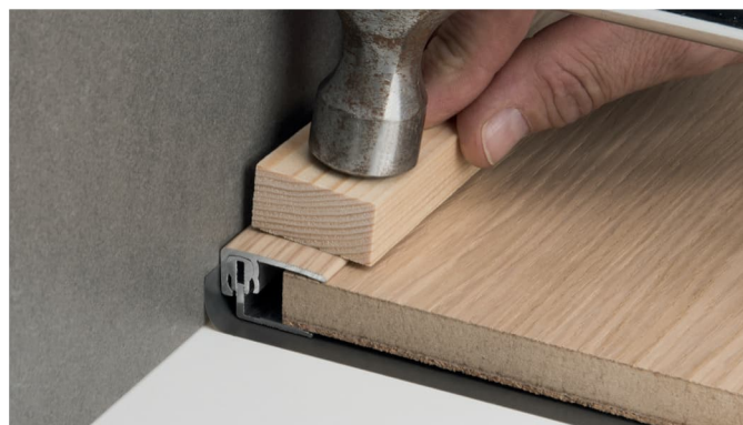
Instalace ukončovacího profilu hliníkového
